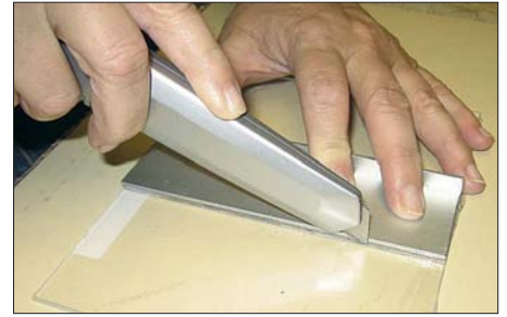
Bild 6: Bei dünnerem Bauglas reicht das Anritzen von einer Seite aus.
