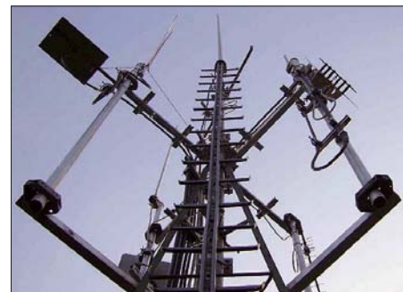
70- und 23-cm-Antennenanlage bei DB0BOS (Böllstein/Odenwald) Foto: DG9FCJ
