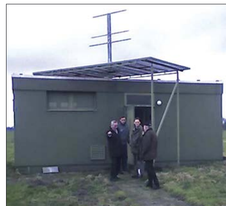
Bild 4: Betriebsgebäude mit darauf angebrachter „OM“-Antenne für die Anflugbefehung Fotos: DK1KQ
